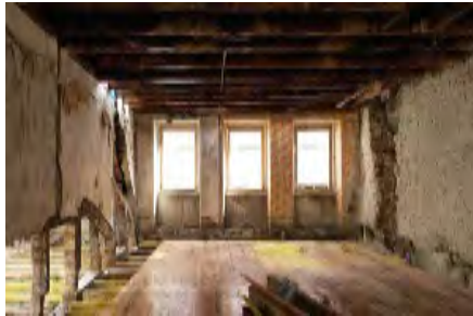
travaux en cours
